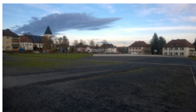
Blick von Südwesten über das Baugrundstück
