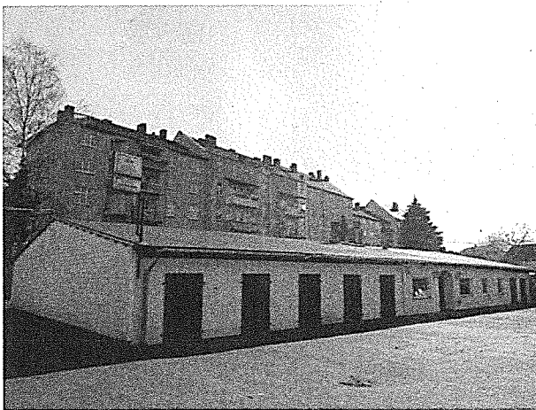
Südliches Gebäude (Rückbau) von Nordwest
