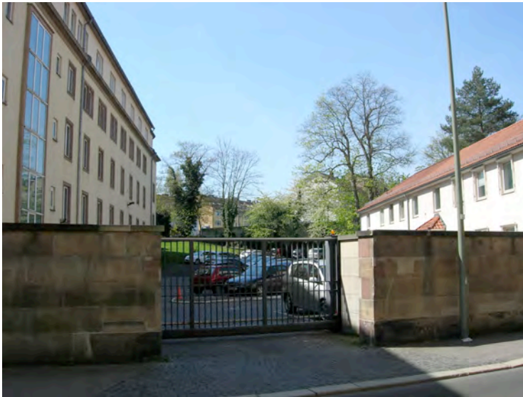
Verwaltungsgerichtshof, Zufahrt Friedrichsstraße 22
