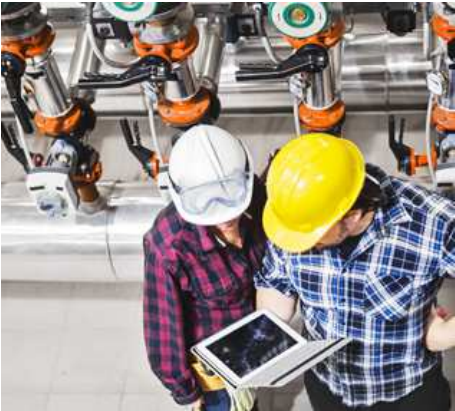
Wärme- und Heizungsanlagen
