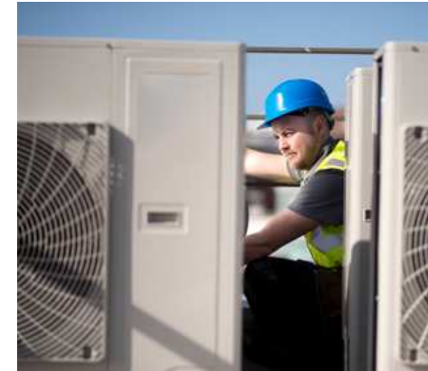
Kälte- und Klimaanlage
