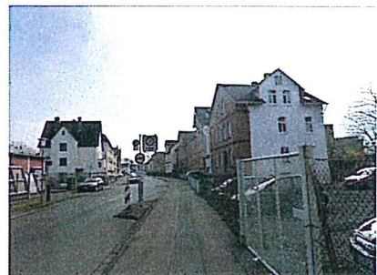
Südlicher Bereich der Agathofstraße mit der an das Plangebiet anschließenden Wohnbebauung.
