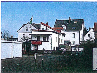
Bebauung südlich des Geltungsbereichs
