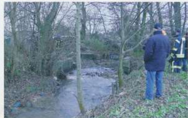
Abb. 13: Wickerbach nach der Wehrsprengung
