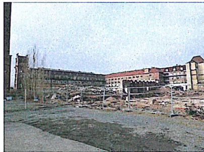
Blick von Süd-Westen auf die Schuttablagerungen der durchgeführten Abbruchmaßnahmen
