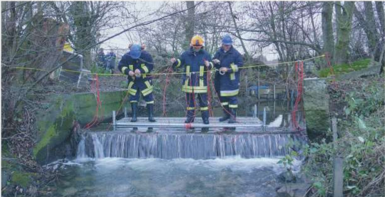
Abb. 11: Vorbereitung der Sprengung
