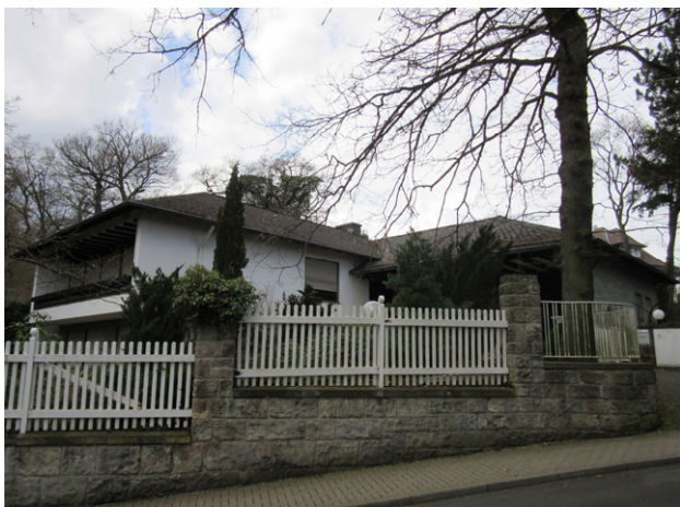
Ansicht von der Klinikstraße
