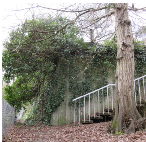
Betonmauer zur Geländeabfangung im Süden
