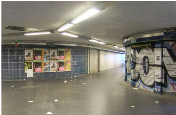
Abbildung 78: Unterführung am Holländischen Platz
