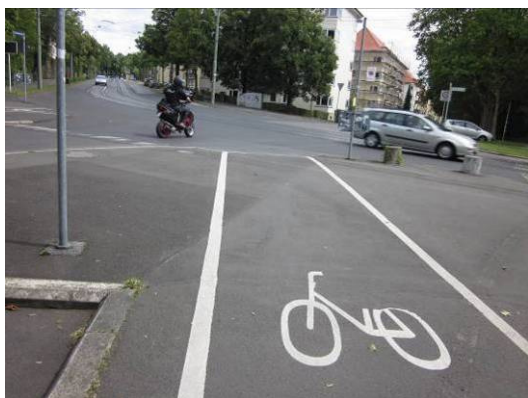
Abbildung 62: abruptes Ende der Radverkehrsanlage (Goethestraße / Freiherr-vom-Stein-Straße)
