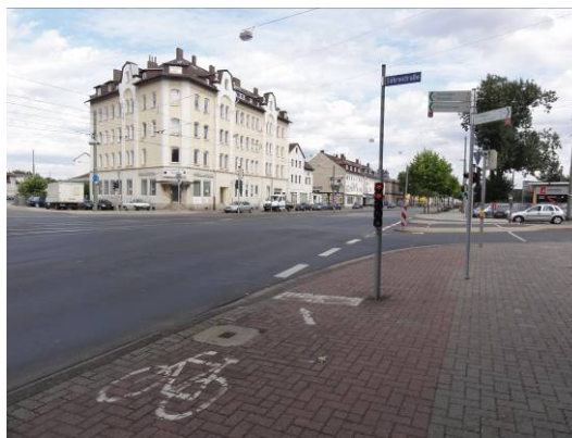
Abbildung 58: Separate Radverkehrssignalisierung zur sicheren Querung der Kreuzung
