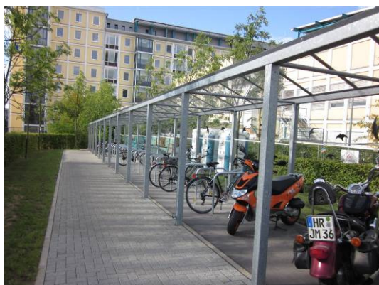
Abbildung 66: Fahrradabstellanlage am Klinikum
