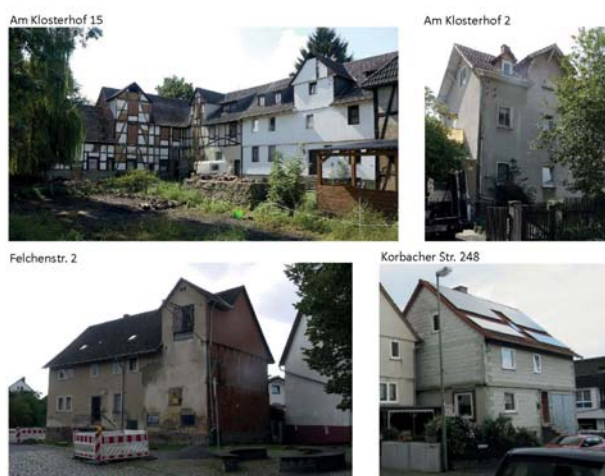
Beispiele hoher Sanierungsbedarf
