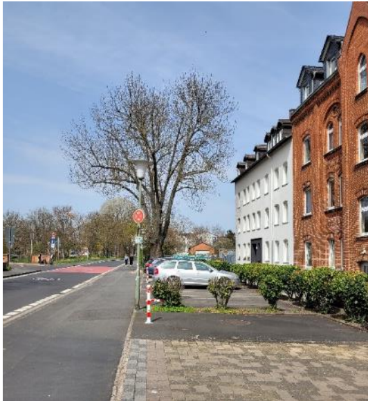
Abbildung 3: Blick auf Bestandsbebauung der Fiedlerstraße Haus-Nr. 2 und 4, Blickrichtung Norden
