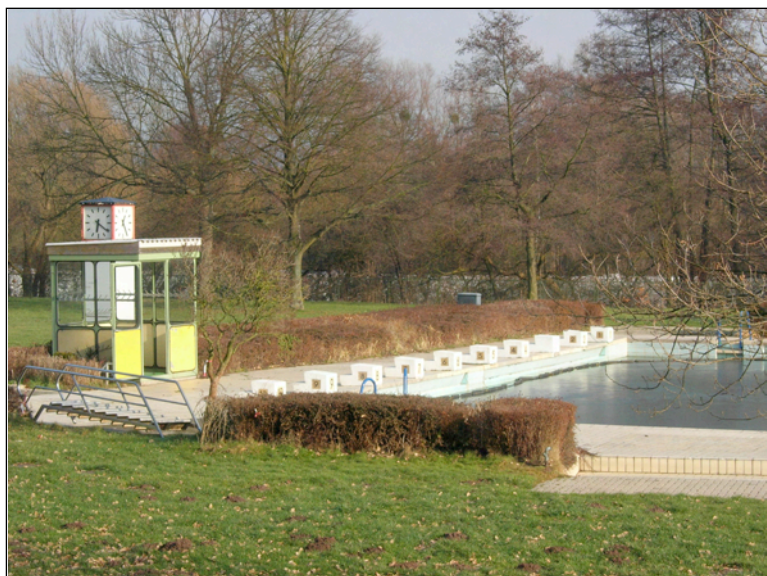
Schwimmerbecken, Kabine Badeaufsicht
