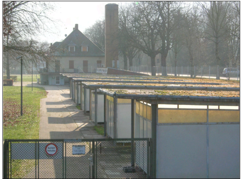
Umkleidekabinen, im Hintergrund Heizzentrale und Empfangsgebäude
