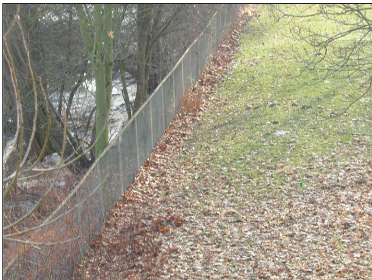
Abzäunung Schwimmbadgelände, Fuldaufer
