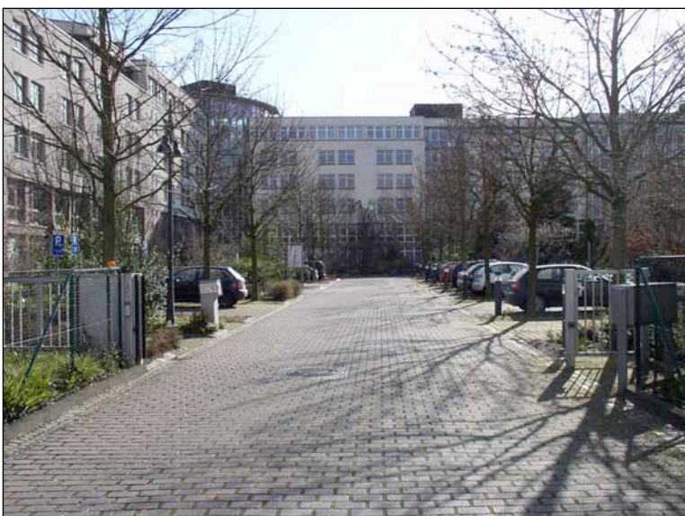
Hofseite des Gebäudekomplexes BG Gartenbau / Bundesknappschaft
