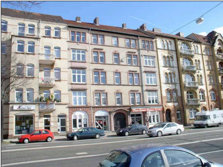
Gründerzeitliche Bebauung an der Frankfurter Straße
