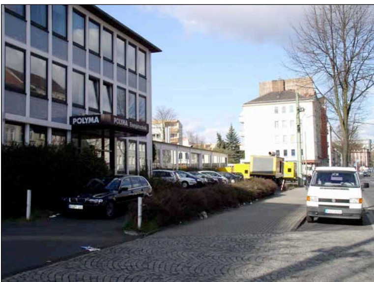
Polyma Energiesysteme GmbH, Kopfbau, Gebäude Frankfurter Straße 112
