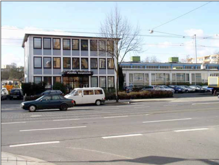
Polyma Energiesysteme GmbH, Kopfbau und Werkhalle
