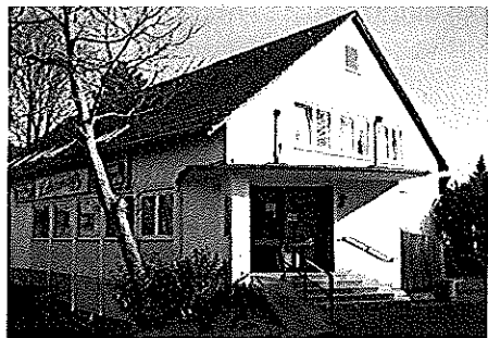
Traufseite Nord bzw. Eingangsseite West
