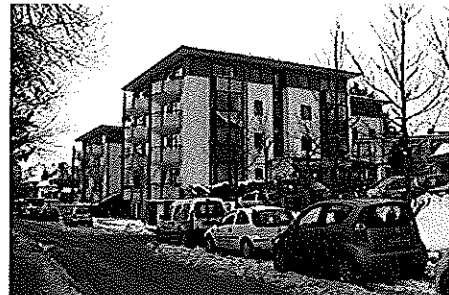
und Haus am Stiftsheim Firnsbachstraße 6
