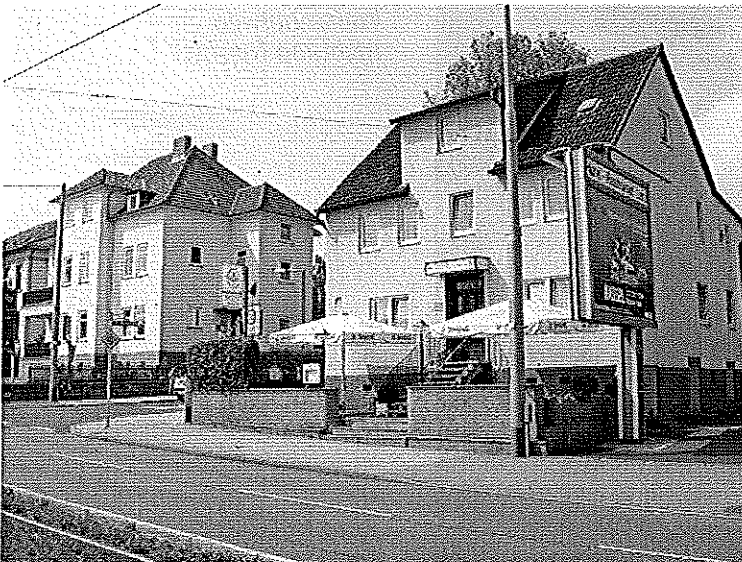
Hotel Frankfurter Straße 176
