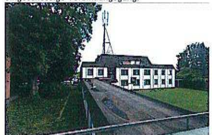
Blick über den eingeschossigen Verbindungsgang
