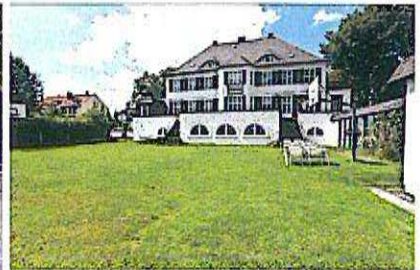
Blick auf die Villa vom Innenhof aus. Rechts der eingeschossige Verbindungsgang.
