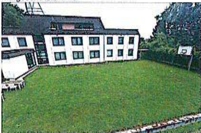
Blick in den Innenhof und auf das Hotelgebäude.
