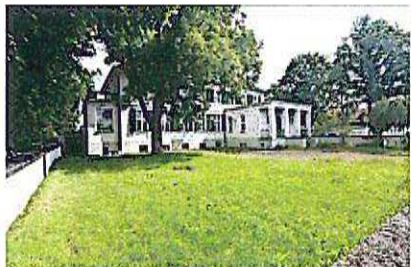
Freiflächen an der Frankfurter Straße
