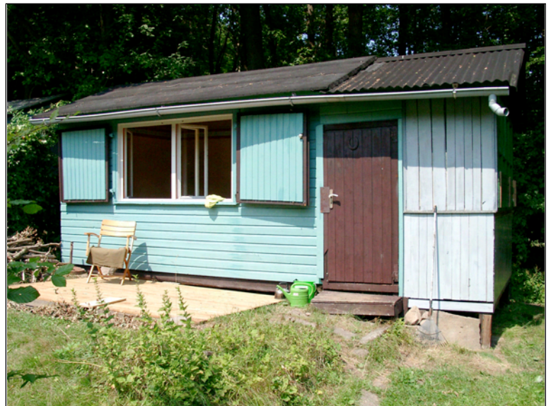
Laube, Dachdeckung rechts mit Bitumenwellplatten
