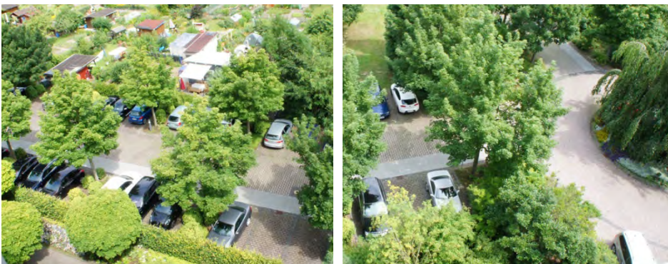
Blick über die Stellplatzanlage (parallel zur Bosestraße)
