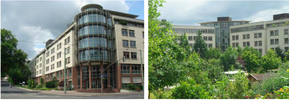
Eingangssituation Frankfurter Straße / Bosestraße und Rückansicht
