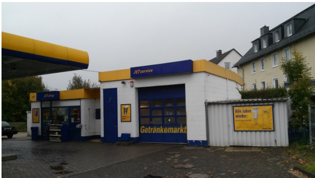
Ansicht Tankstelle von Westen
