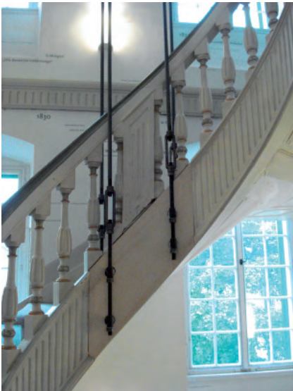
Konstruktion zur Stabilisierung der historischen Treppe
