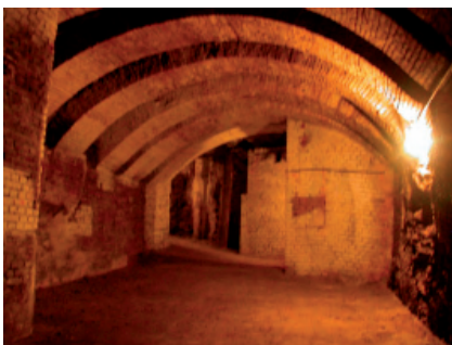
Foto eines Gewölbekellers der Stollenanlage
