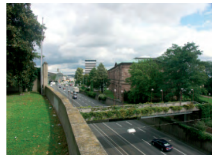
Brücke über die Frankfurter Straße
