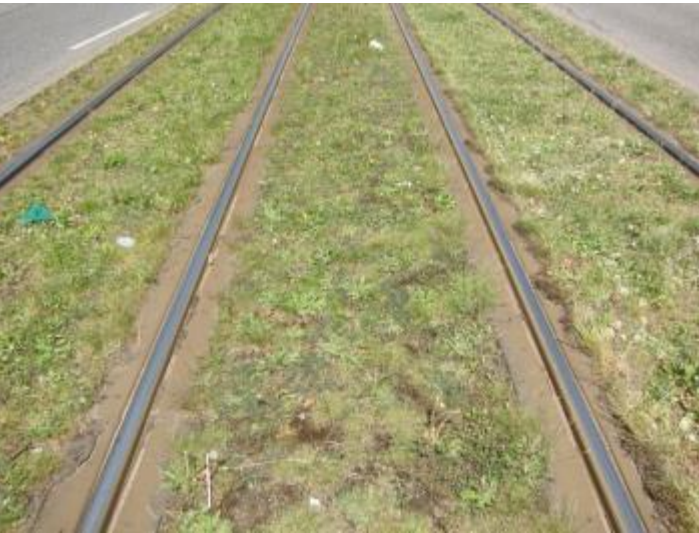
Beispiele Rasengleis ohne Bewässerungssystem in Kassel
