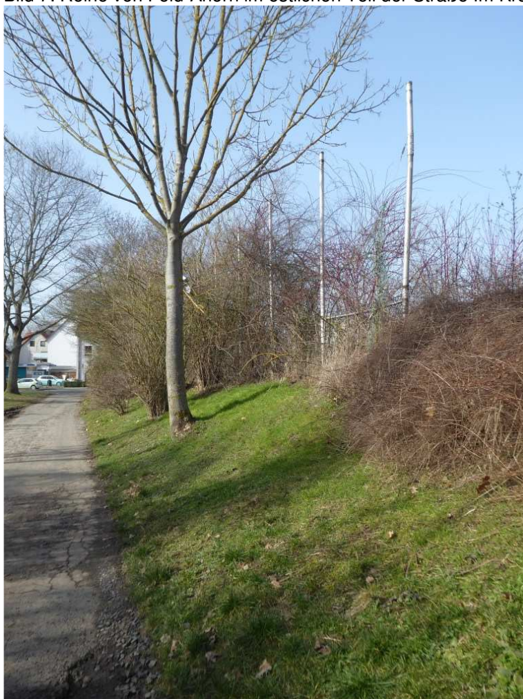
Bild 8: Böschung im westlichen Teil der Straße Im Kreuzhof
