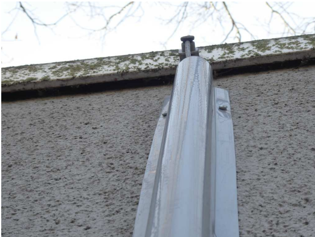
Bilder 13 und 14: weitere Beispiele für Spalten an Dachanschlüssen
