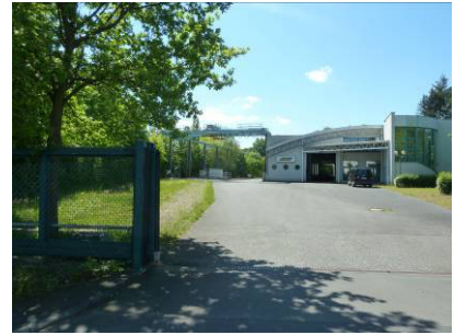
Blick auf die bestehende Halle von Norden
