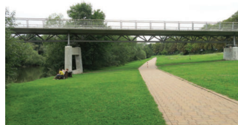
Intensiv gepflegte Flächen an der Gärtnerplatzbrücke
