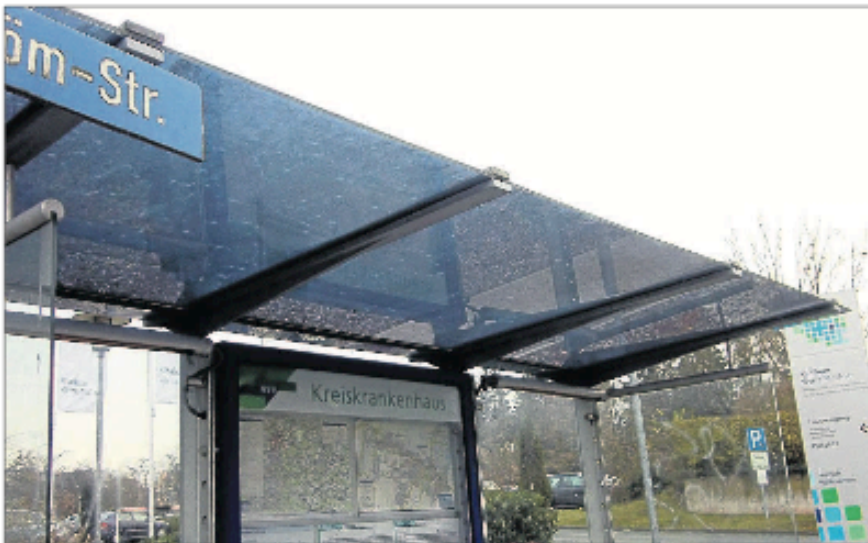
Am Eschweger Krankenhaus erfolgte die Umrüstung mit einer getönten Folie.
