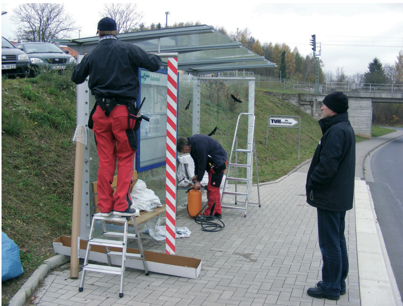
Beschichtung des Glasdaches an der Haltestelle Bahnhof in Eschwege-Niederhone
