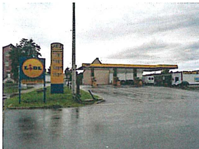
Tankstelle (Blick von Süden)
