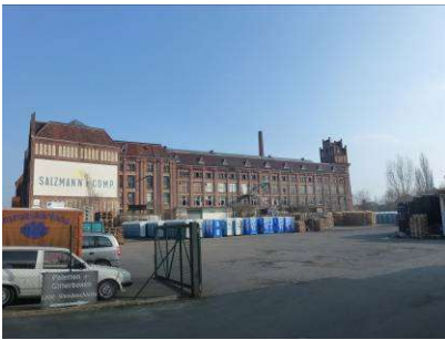
Blick von Westen über das Nachbargrundstück auf das Bestandsgebäude
