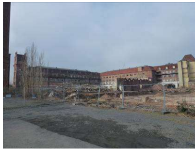
Blick von Süd-Westen auf die Schuttablagerungen der durchgeführten Abbruchmaßnahmen
