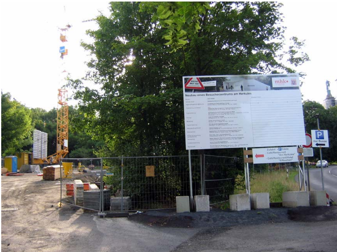
Beginn der Bauarbeiten Besucherzentrum am Herkules Juli 2009
