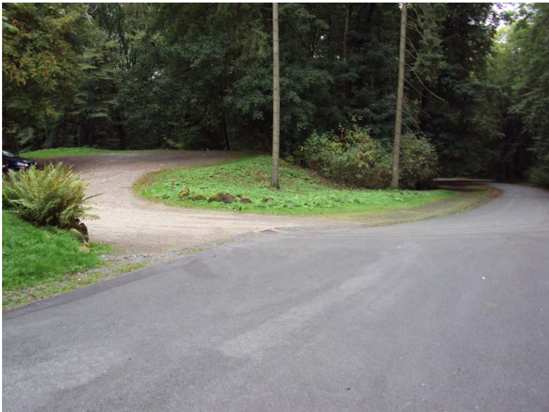
Parkplatzzufahrt am Kaskadenrestaurant
