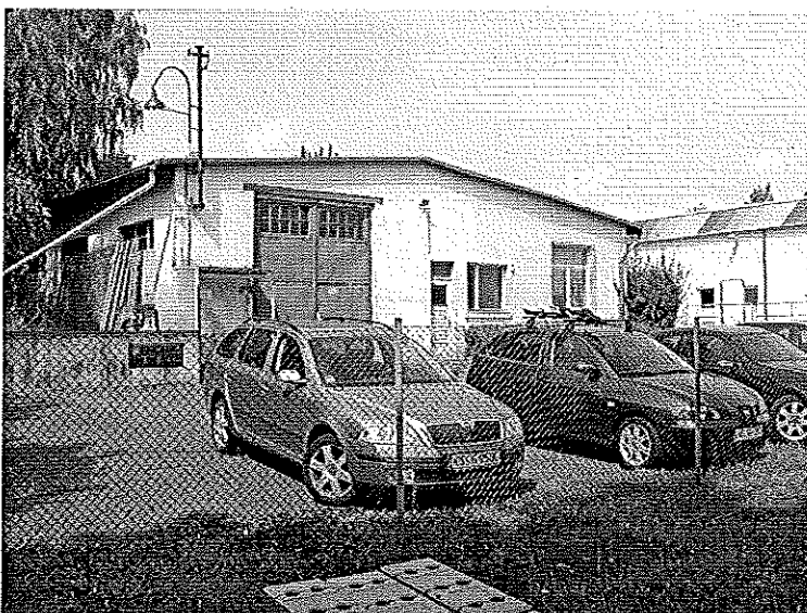
Rückwärtiges Gebäude Töpfenhofweg 42
