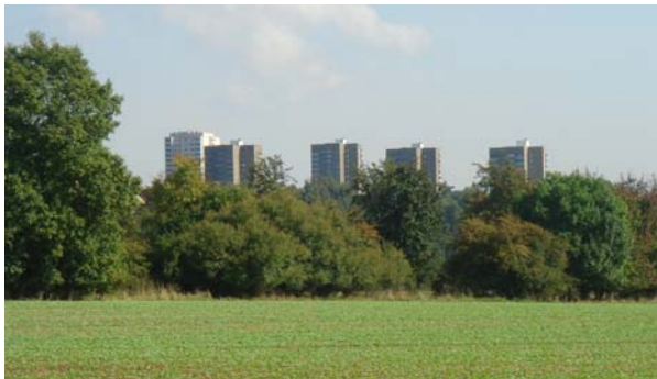
markante Brückenhofsiedlung, Oberzwehren Hochhäuser
