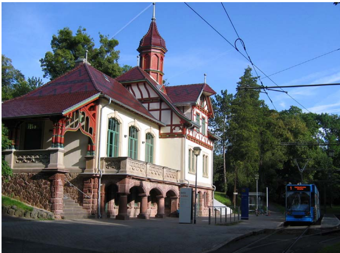
Saniertes Besucherzentrum am Schloss
