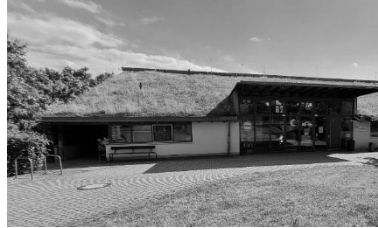
Abbildung 2-6: Kindertagesstätte im Quartier West mit Dachbegrünung und Solaranlage auf der Rückseite
