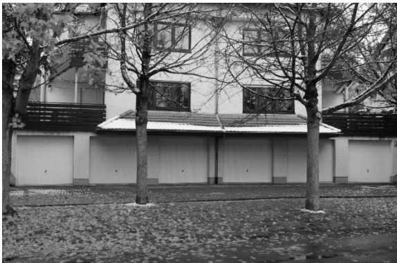
Abbildung 2-36: Vorbildlich gelöst: Grünfläche und Bäume vor den Garagen, seitliche Zufahrt mit Rasengittersteinen
