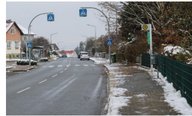
Abbildung 2-19: Fehlender Wetterschutz Haltestelle Rheinstahlring stadtauswärts
