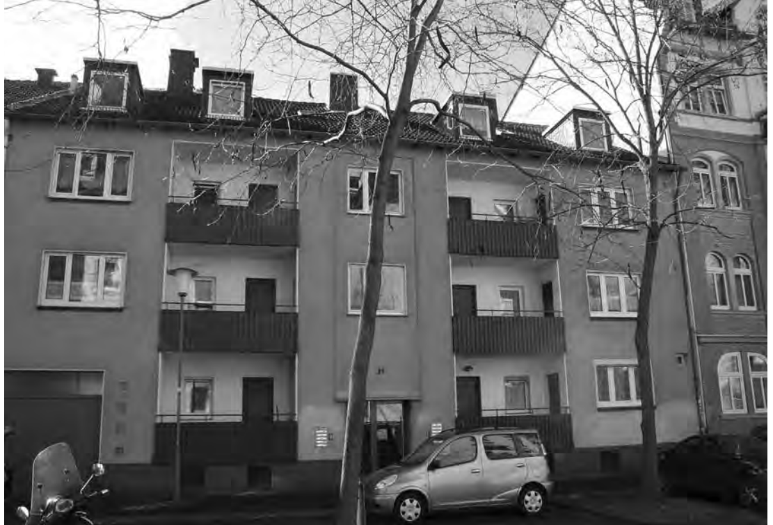
Wohnungsbestand der Wiederaufbauplanungen
