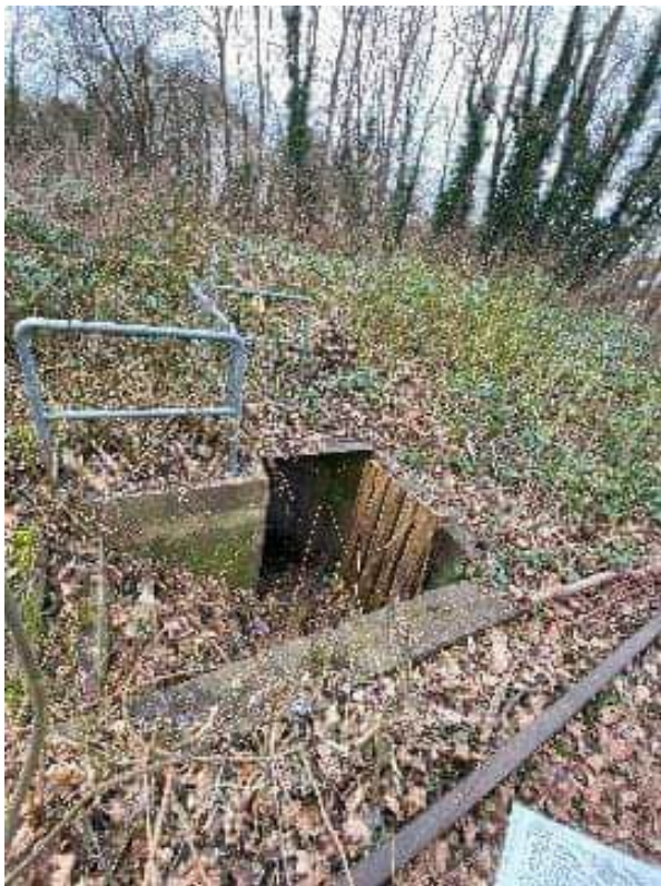
Abb. 2-22: Eingang zur Verrohrung des Angersbachs innerhalb des Geltungsbereichs
