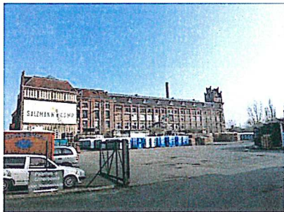
Blick von Westen über das Nachbargrundstück auf das Bestandsgebäude
