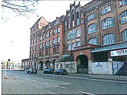
Blick von Norden auf das denkmalgeschützte Bestandsgebäude
