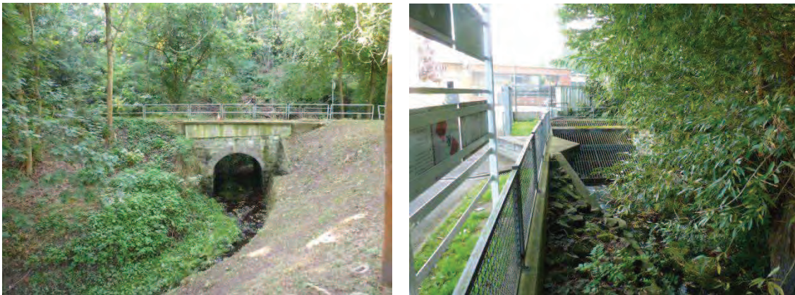
Links: Angersbach / Unterquerung der Schillerstraße nördlich von Rothenditmold
