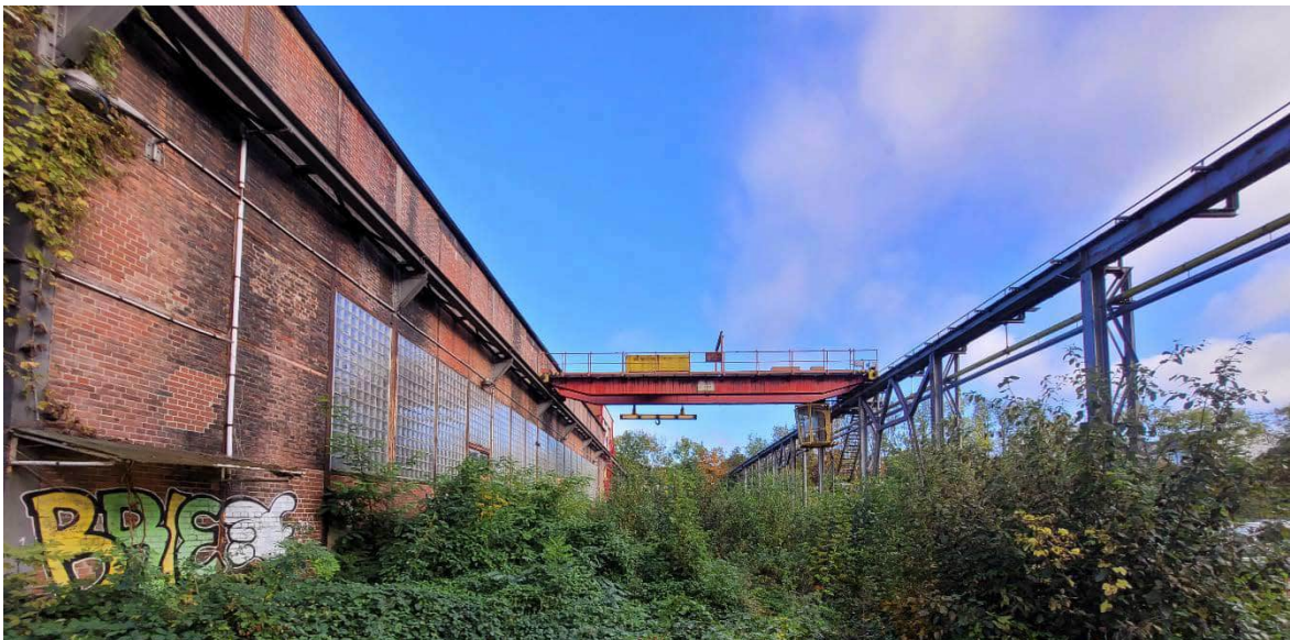
Abb. 4 Kranbahn RK3 im Osten des Areals, eigene Fotoaufnahme.
