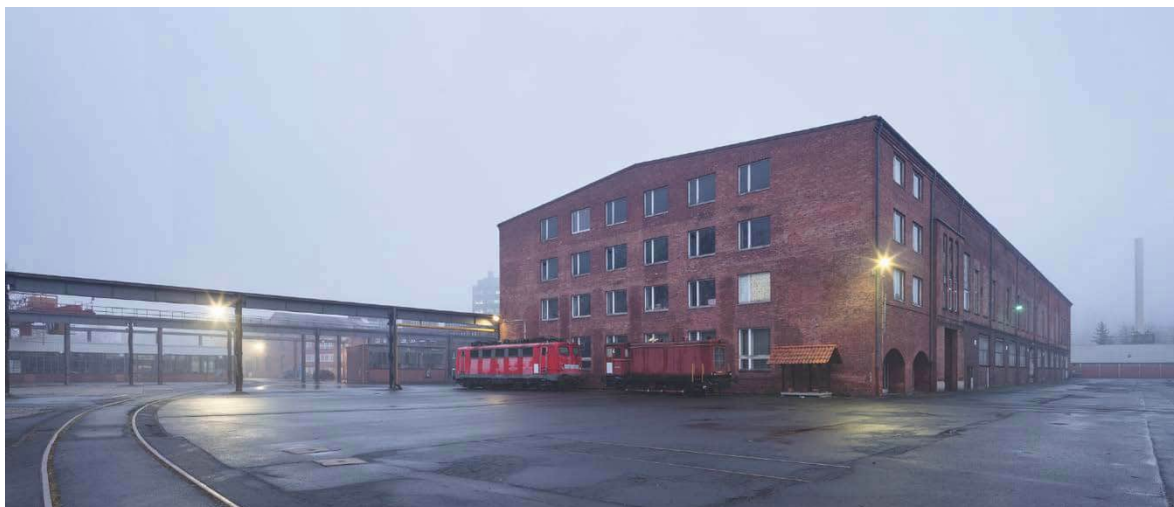
Abb. 28 Werkhalle / Vorbereitungshalle, R 10 sowie Kranbahn RK1
