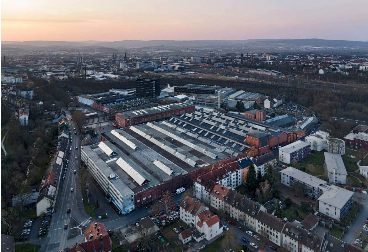
Abb. 19 Drohnenaufnahme zum Gesamtanlage, Quelle HG Esch
