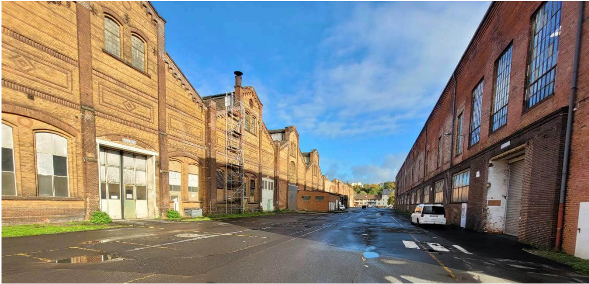
Abb. 3 Sichtachse zwischen Kesselschmiede (links) und Vorbereitungshalle (rechts), eigene Fotoaufnahme.
