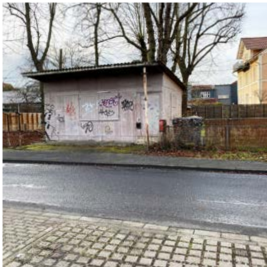
Abb. 34 (links unten): Leerstehender Kiosk gegenüber der Grundschule (Foto: plan zwei)
