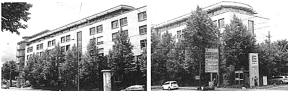
SVLFG-Gebäude, Ansicht Frankfurter Straße mit Lindenreihe im Vordergrund
