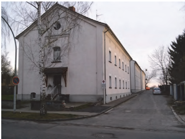
Westlich angrenzende Wohnbebauung (Denkmalensemble) von Theodor-Fliedner-Straße
