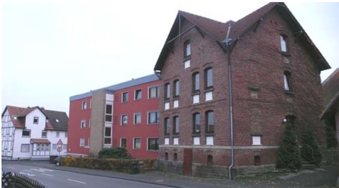
Situation an der Korbacher Straße
