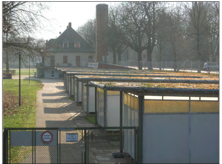
Umkleidekabinen, im Hintergrund Heizzentrale und Empfangsgebäude
