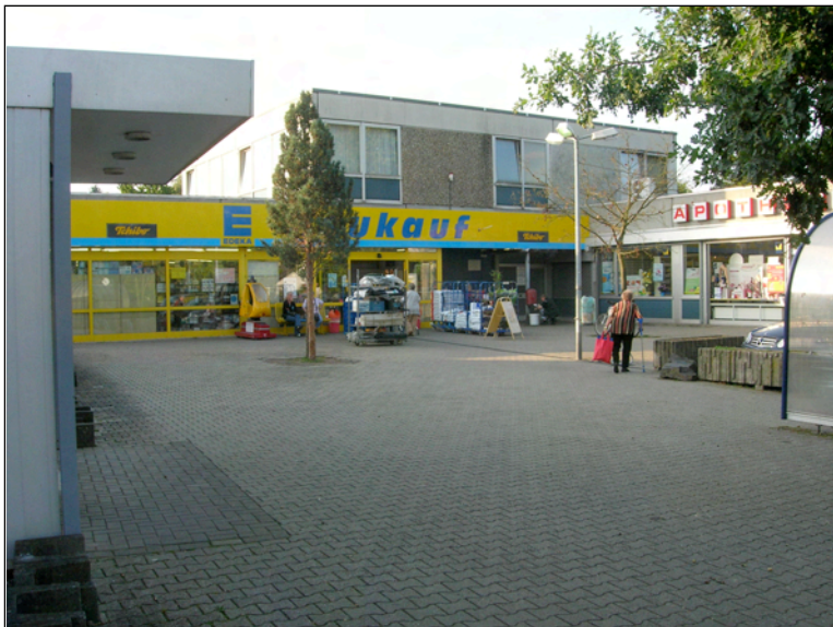
Hof- und Eingangsbereich, Zugang Lebensmittelmarkt, Obergeschoss mit Arztpraxen
