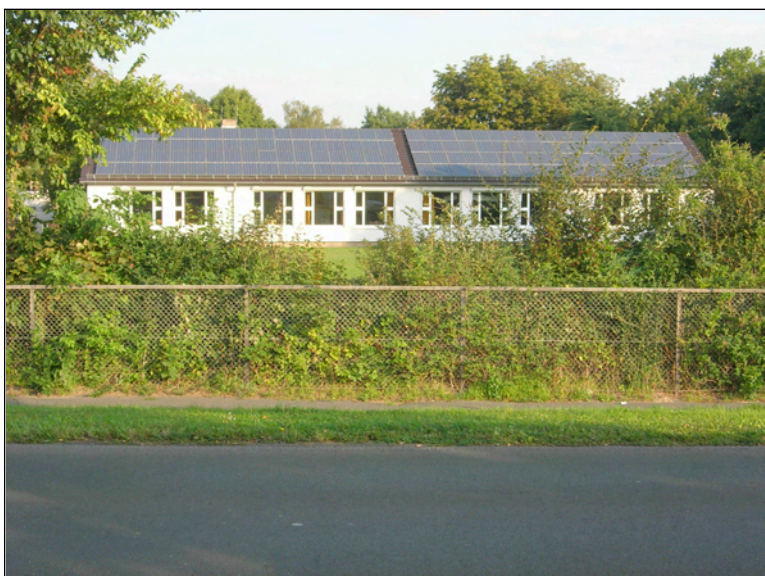
Schule nördlich des Forstbachweges
