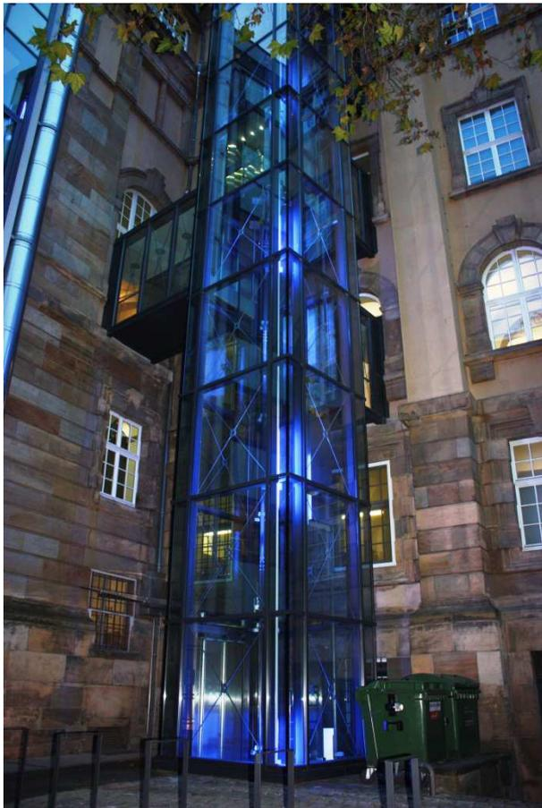
Die Zugänge von Aufzugstüren zu den einzelnen Geschossen wurden über freitragende und teilweise mit Alu-Paneelen verkleideten Brücken erschlossen.
