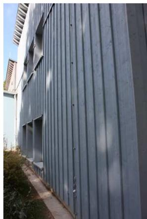
Der Anbau ist analog zum Gebäudebestand, in einer Holzständerkonstruktion auf einem massiven Sockel- bzw. Untergeschoss ausgeführt.
