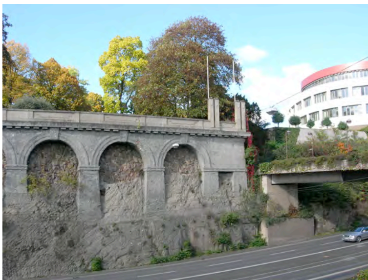
Substruktionsbögen und Fußgängerbrücke, Frankfurter Straße, rechts Elisabeth-Krankenhaus
