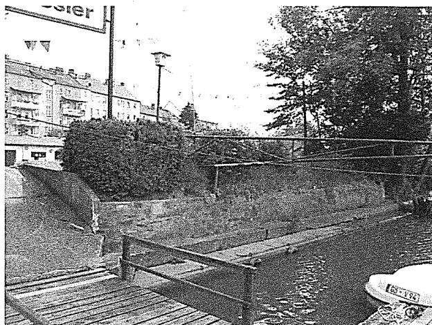
Natursteinmauer im südlichen Uferbereich
