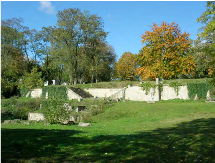
Freitreppenanlage der ehemaligen Henschelvilla
