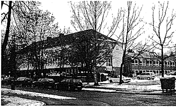
Einmündung Sternbergstraße / Ortelsburger Straße
