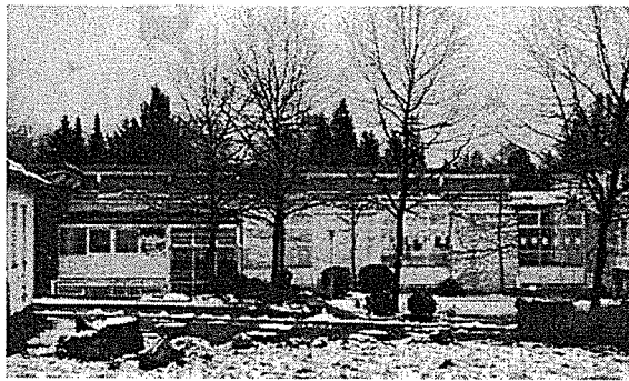
Erweiterungsbau aus den 80er Jahren des 20. Jhrdts.
