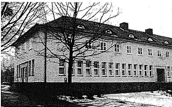
Gebäude der ehemaligen Landesfeuerweherschule Ansicht Ortelsburger Strasse
