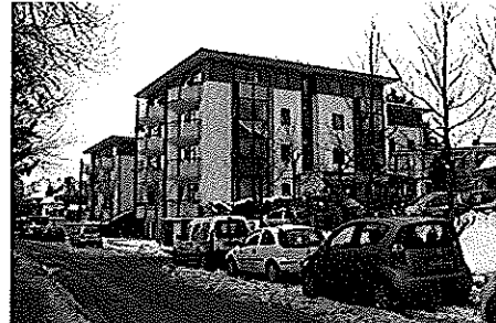
und Haus am Stiftsheim Firnsbachstraße 6
