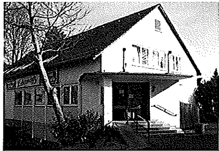
Traufseite Nord bzw. Eingangsseite West
