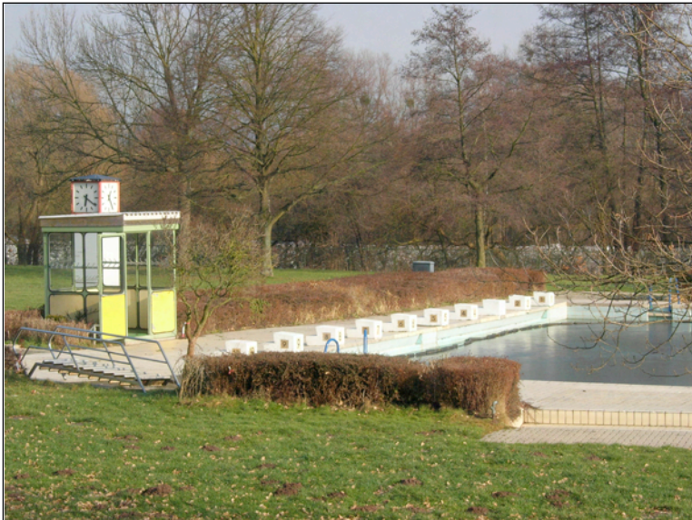
Schwimmerbecken, Kabine Badeaufsicht
