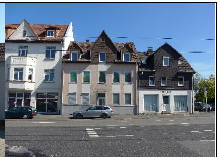
Ecke Frankfurter Str. / Credestraße
