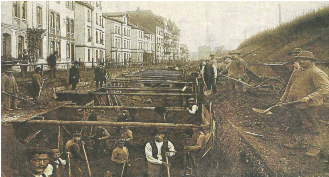
Bau der Mombach-Verrohrung (1911), rechts die noch fast vegetationsfreie Böschung des Unterstadtbahnhofs; Quelle: HNA, 07.08.2013
